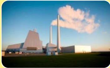
◀ DONG (E2) Avedore: โรงไฟฟ้าเชื้อเพลิงถ่านหิน ประเทศเดนมาร์ก กำลังไฟที่ผลิต 260 MW ทำความสะอาดในส่วนของ Super heater Furnace
