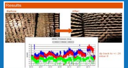
ภาพและกราฟแสดงผลก่อนและหลังการทำความสะอาด ครีบนายความร้อนใน HRSG
