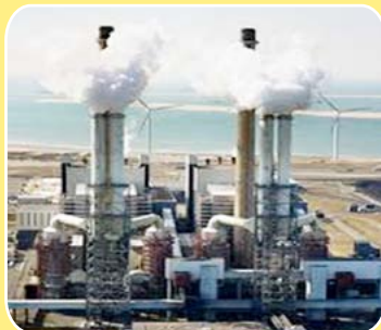
◀ E-ON Maasvlakte Unit 1: โรงไฟฟ้าเชื้อเพลิงถ่านหิน ประเทศเนเธอร์แลนด์ กำลังไฟที่ผลิต 520 MW ทำความสะอาดในส่วนของ Coal Super heater boiler full load
