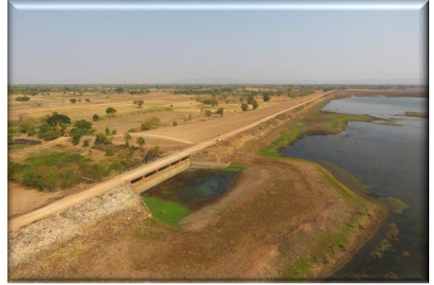
โครงการจัดหาและติดตั้งเครื่องมือตรวจวัดพฤติกรรมเขื่อนแบบอัตโนมัติอ่างเก็บน้ำ บ้านเพชร ตำบลบ้านเพชร อำเภออุทุมพรพิสัย จังหวัดชัยภูมิ : กรมชลประทาน
