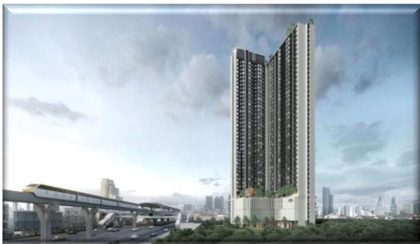
บริหารและควบคุมงานก่อสร้าง โครงการ นิว โนเบิล ศรีนครินทร์-ลาซาล : บริษัท โนเบิล ดีเวลลอปเม้นท์ จำกัด (มหาชน)
