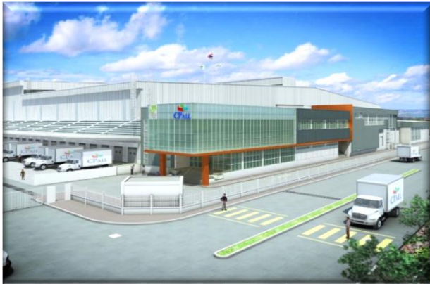
บริหารและควบคุมงานก่อสร้าง โครงการศูนย์กระจาย สินค้า Dynamic Complex Phase 2 : บริษัท ซีพี ออลล์ จำกัด (มหาชน)
