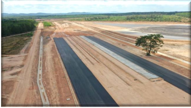
โครงการควบคุมงานก่อสร้างสนามทดสอบระบบเบรก (Brake Performance) จ.ฉะเชิงเทรา : สำนักงานมาตรฐานผลิตภัณฑ์อุตสาหกรรม
