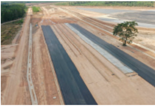
โครงการควบคุมงานก่อสร้างนามทดสอบระบบเบรก (Brake Performance) จ.ฉะเชิงเทรา : สำนักงานมาตรฐานผลิตภัณฑ์อุตสาหกรรม
