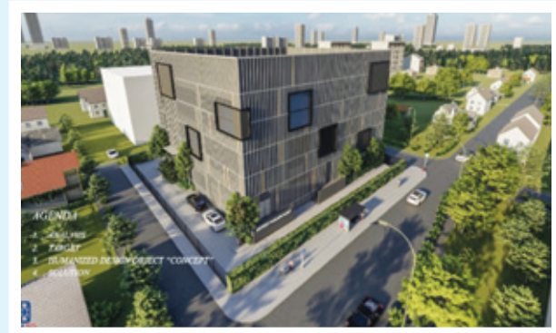
โครงการสัมปทานระบบผลิตความเย็นจากส่วนกลาง (District Cooling) บริเวณพื้นที่เขตพาณิชย์สวนหลวง-สามย่าน : จุฬาลงกรณ์มหาวิทยาลัย
