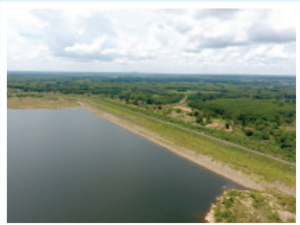
โครงการจัดหาและติดตั้งเครื่องมือตรวจวัดพฤติกรรมเขื่อน ห้วยทา ตำบลบักดอง อำเภอขุนหาญ จังหวัดศรีสะเกษ : กรมชลประทาน
