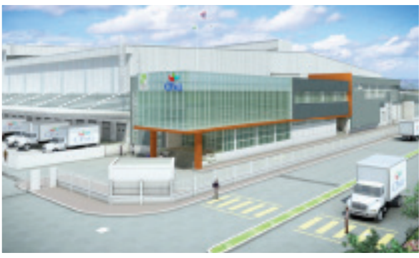
บริหารและควบคุมงานก่อสร้าง โครงการศูนย์กระจายสินค้า Dynamic Complex Phase 2 : บริษัท ซีพี ออลล์ จำกัด (มหาชน)
