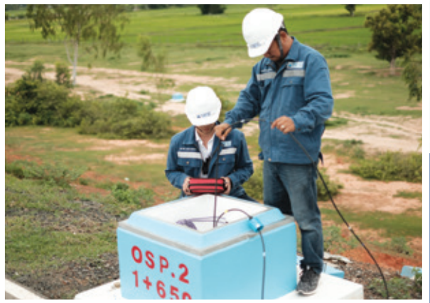
เครื่องมือ Open and Standpipe Piezometer Installation
