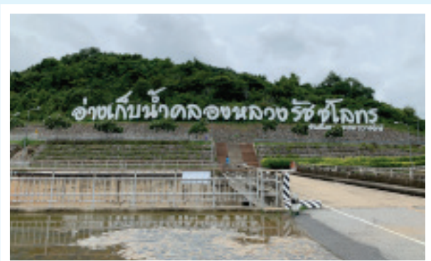
โครงการศึกษาความเหมาะสมและออกแบบวางท่อ เสริมศักยภาพน้ำอุปโภคบริโภค จากอ่างเก็บน้ำคลองสี่แยก- อ่างเก็บน้ำคลองหลวงรัชชโลทร จังหวัดฉะเชิงเทรา: การประปาส่วนภูมิภาค
