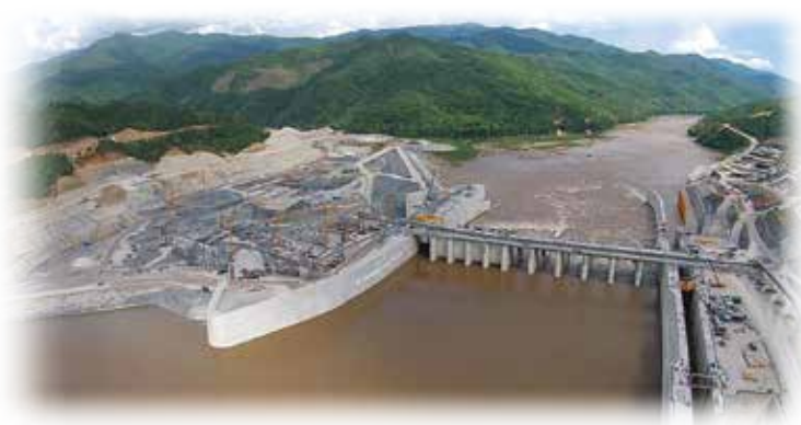
โครงการโรงไฟฟ้าพลังงานน้ำไซยะบุรี สปป.ลาว อีกหนึ่งโครงการที่น้ำภูมิใจของทีมกรุ๊ป
